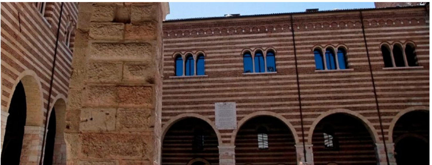
> Palazzo del Comune, interni
